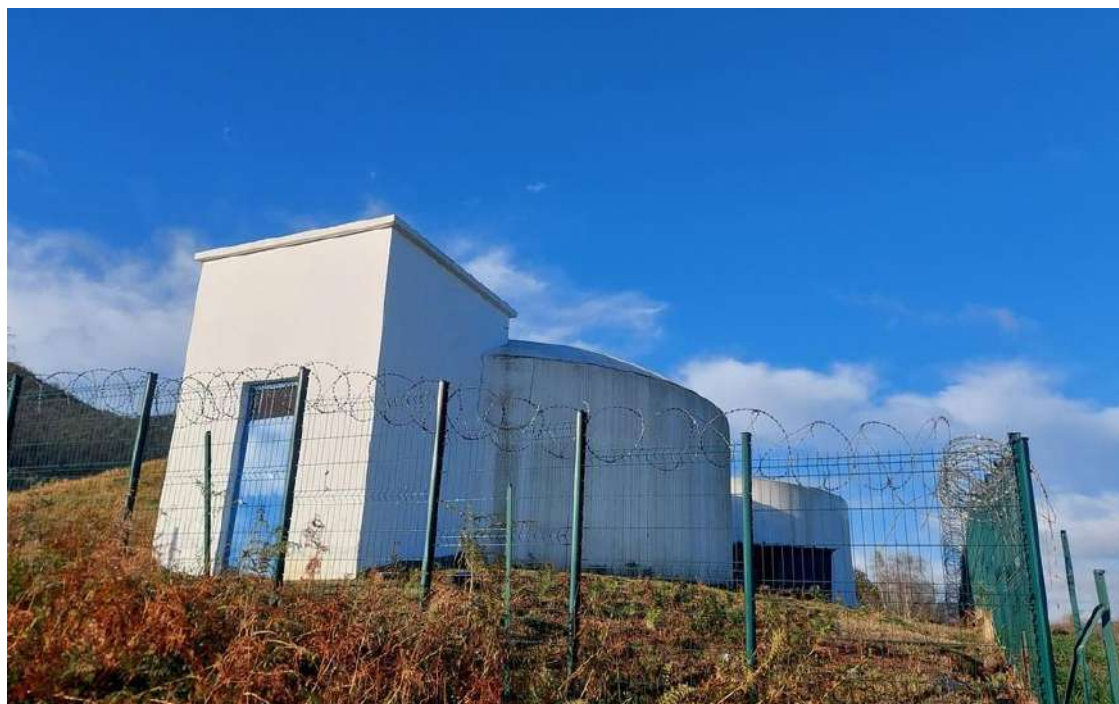
Le château d'eau du Castet sert de réservoir avant une distribution dans les foyers des 4 communes adhérentes.
